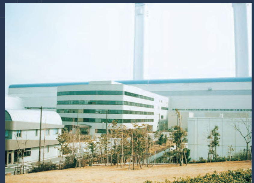
東京電力 横浜火力発電所
